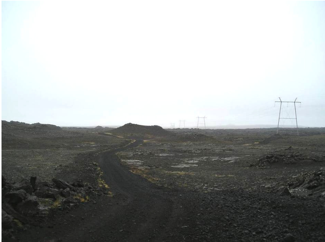
Mynd 15 Forsögulegir klepragígar sem hefur verið þrætt framhjá við slóðagerð. Rauðamelslína 1 í bakgrunni.
